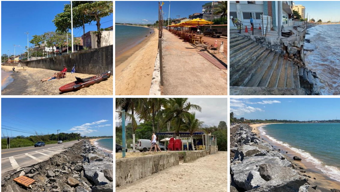
Figura 33: Problemas e Conflitos em relação à Erosão da Orla de Guarapari
